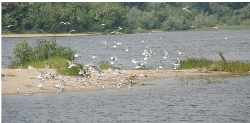
Slika 3: Gradnja otokov kot ukrep za vzpostavitev habitata za vodne vrste ptic ob zapuščeni gramoznici (vir: BirdLife 2017)
