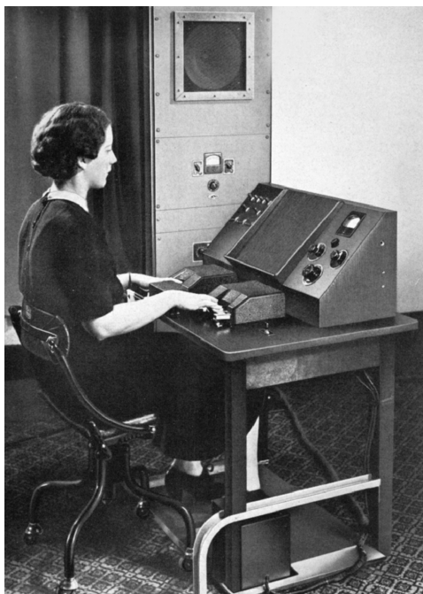
Slika 3: Na sliki je gospa Harper, ki demonstrira uporabo naprave Voder. Naprava je ročno vodena preko tipkovnice (Vir: [6]).
