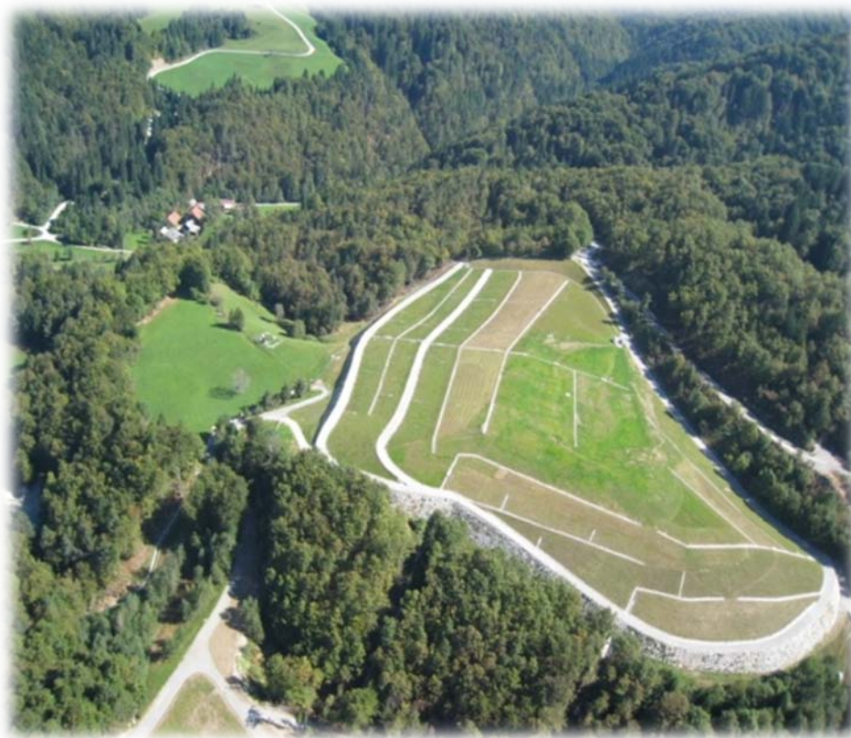
Slika 1: Odlagališče hidrometalurške jalovine Boršt (arhiv RŽV).
