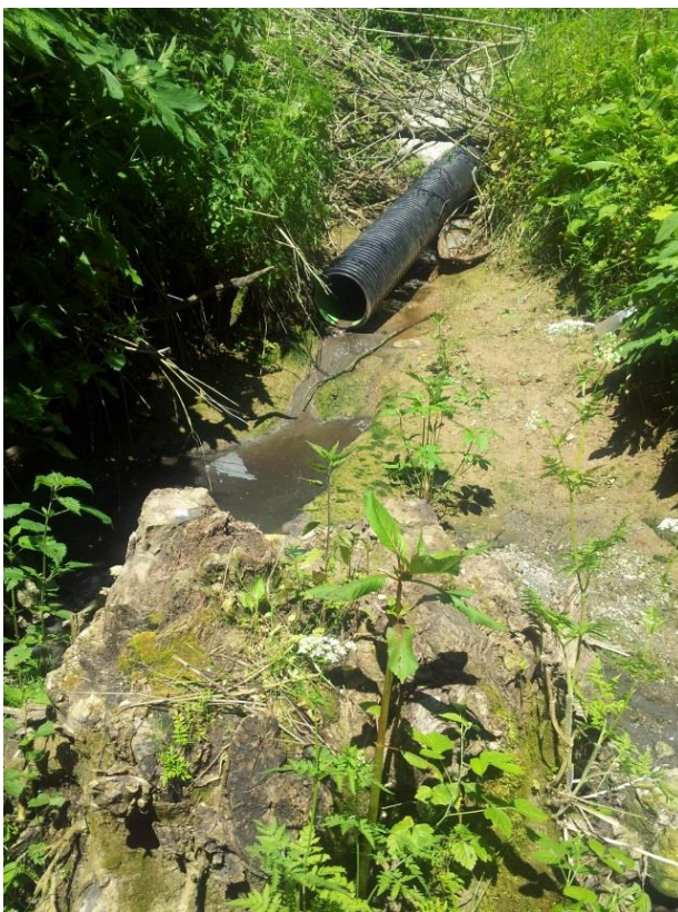
Slika 17: Izток iz vaškega kanala (Foto: Kaja Erjavec, 2013)
